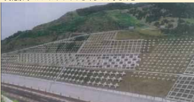
《地図に残った現場》 愛媛県松山市の新設国道で法面対策行った:11ヶ月頑張りました。
